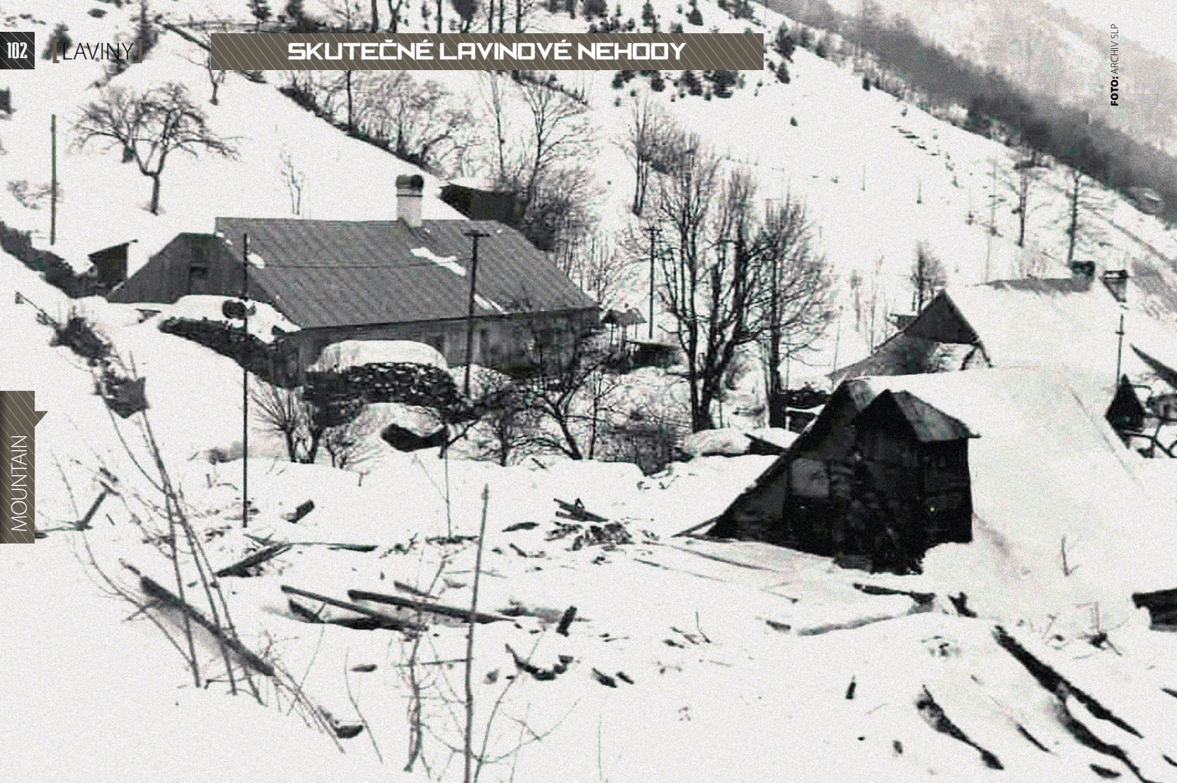
TROSKY ZNIČENÝCH DOMŮ V OBCI TURECKÁ
